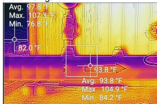
Figura 2. Lectura térmica del pozo AJX1025.
